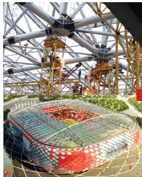
Системы многоточечного раскручивания каркасов крыш стадионов "Спартак" в г. Москве, "Рубин" в г. Казани и "Фишт" в г. Сочи.
