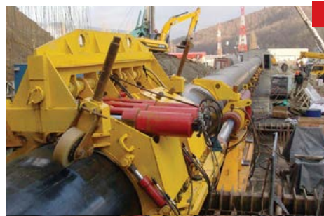
Установка УПТ-700 проталкивания труб в туннельном переходе для транспортировки нефтепродуктов, Краснодарский край.
