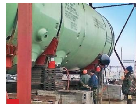
Система синхронного подъема объекта для монтажа корпуса реактора АЭС ВВЭР-1000, г. Волгодонск.
