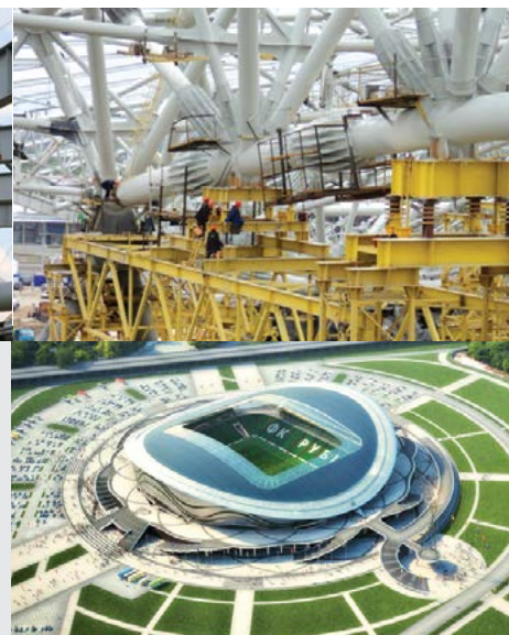
Системы многоточечного раскручивания каркасов крыш стадионов "Спартак" в г. Москве, "Рубин" в г. Казани и "Фишт" в г. Сочи.
